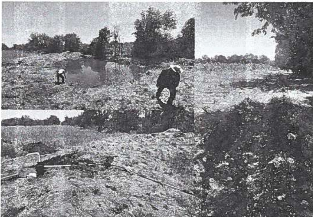
Imagen 1. Represa que acumula el sobrante de agua. Sistema para extracción de agua para su posterior almacenamiento en tinacos. Bordo que conduce el agua de la acequia.
