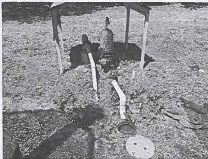
Imagen 14. Pozo "San Mateo".
